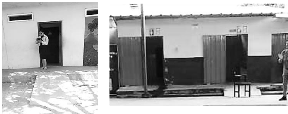
Figura 4. Servicios higiénicos en escuela regular y especial.
